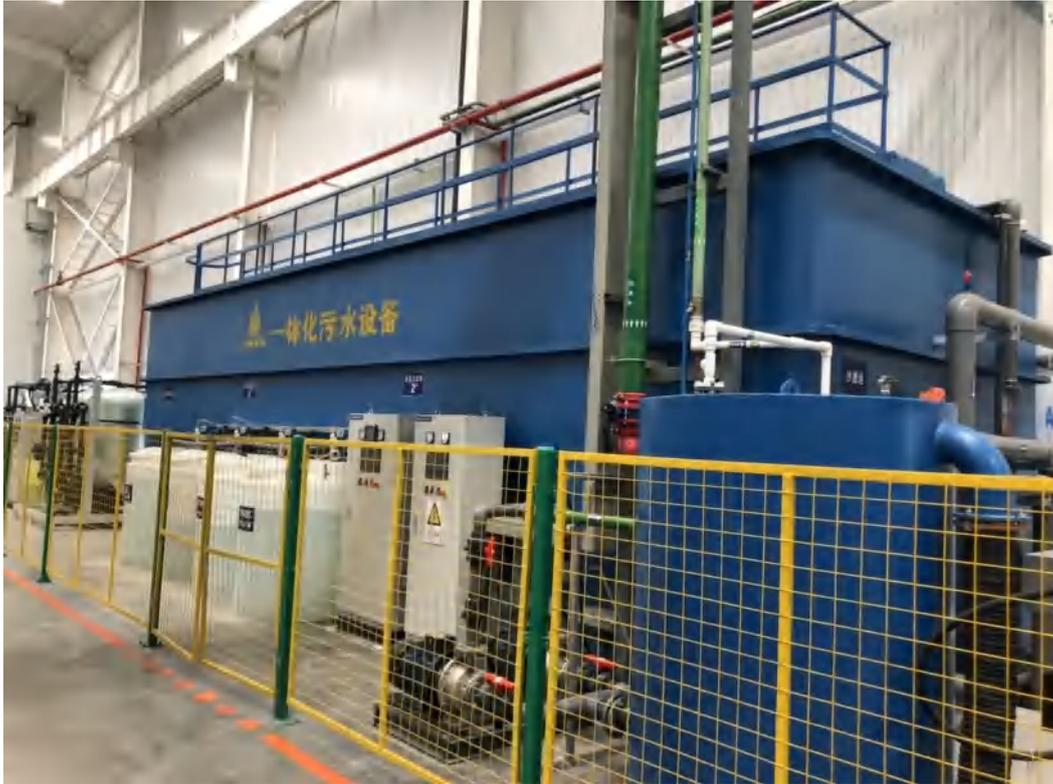
图4-2 生产废水处理设施图
