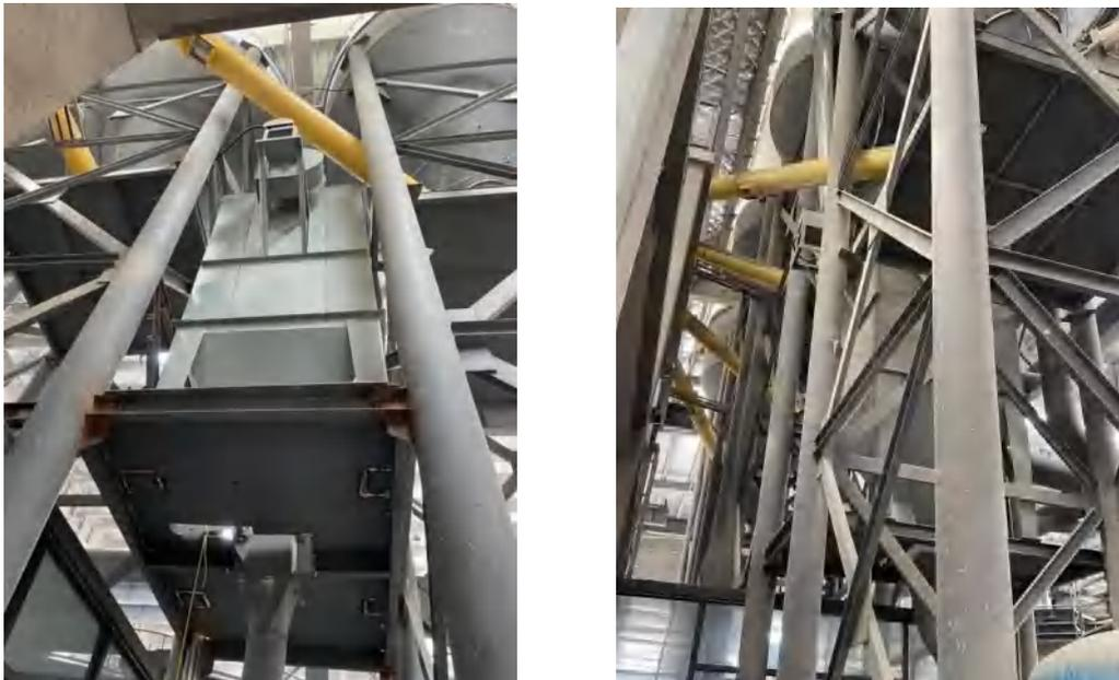
图 3-2 水泥筒仓粉尘废气处理设施图
