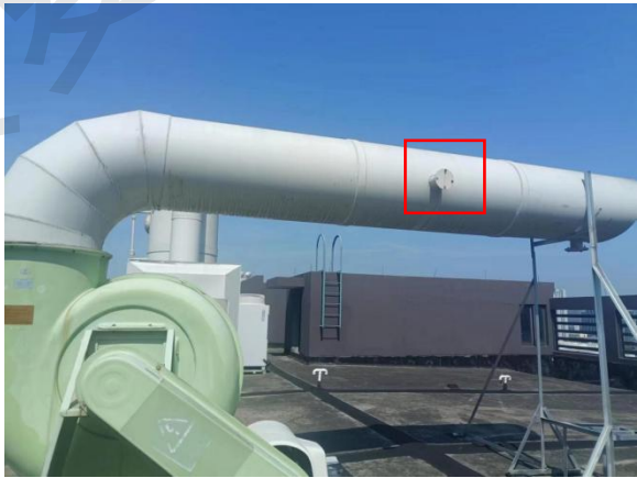
有机废气废气处理设施监测孔
