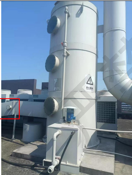
有机废气废气处理设施（活性炭）
