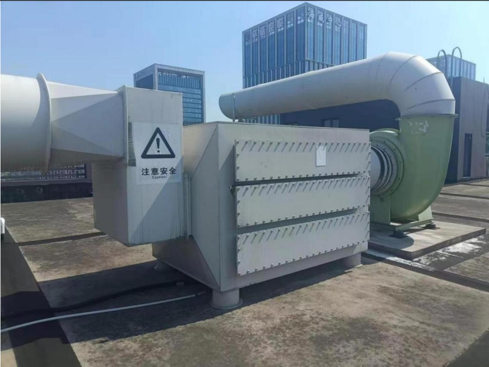
有机废气废气处理设施（活性炭）
