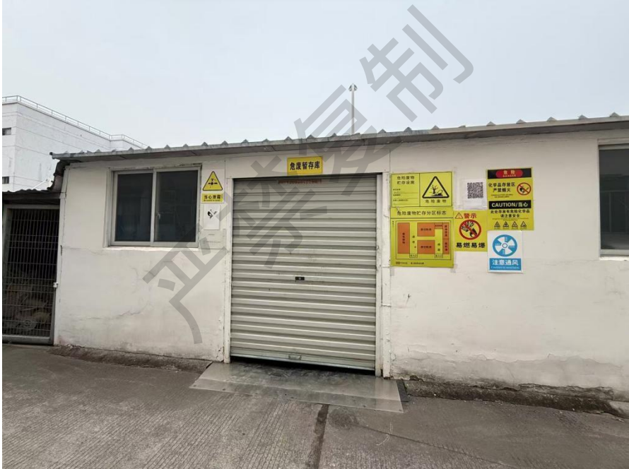
危险废物仓库
