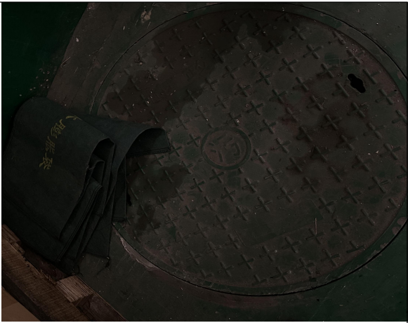
危废仓库收集池
